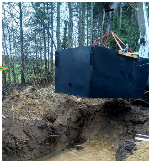
Karret i genbrugsplast løftes på plads i udgravningen.
